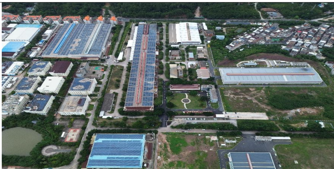
项目东侧（工业厂房）
