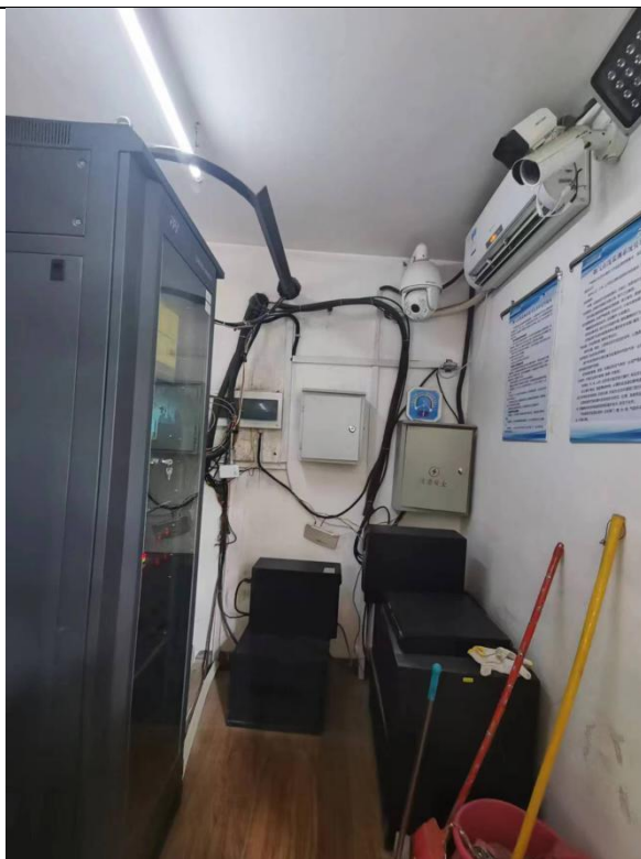
废气在线监控
