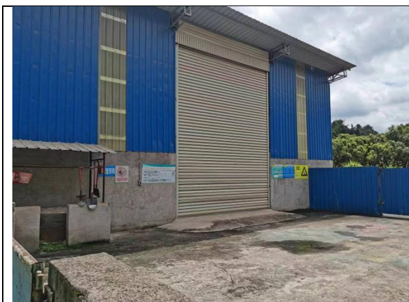
危险废物贮存库
