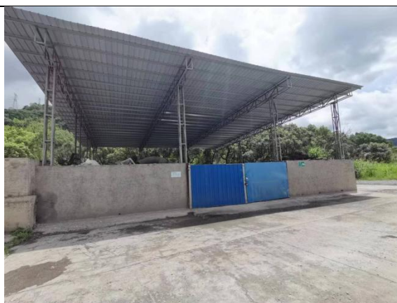
一般固废暂存库
