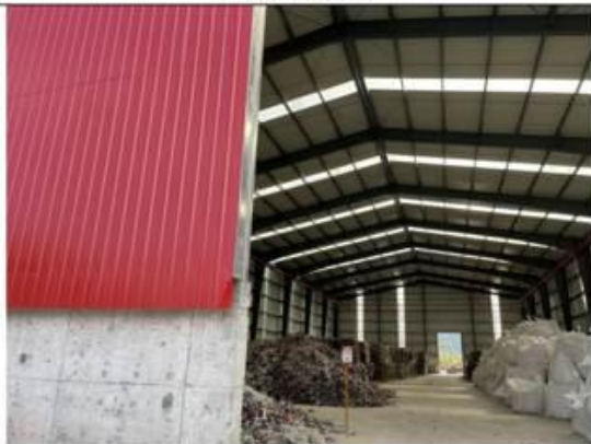
替代燃料库区
