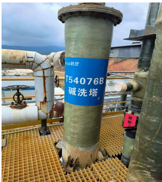
生产区缓冲罐尾气收集及废气处理
