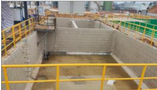
各种回收槽：夯实素土+不小于 200mm 厚水泥铺面+ 防渗五油三布+环氧树脂漆
