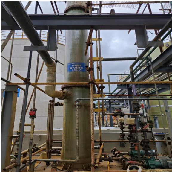
罐区废气排气筒及废气处理设施 一次盐水车间废气排气筒及废气处理设施
