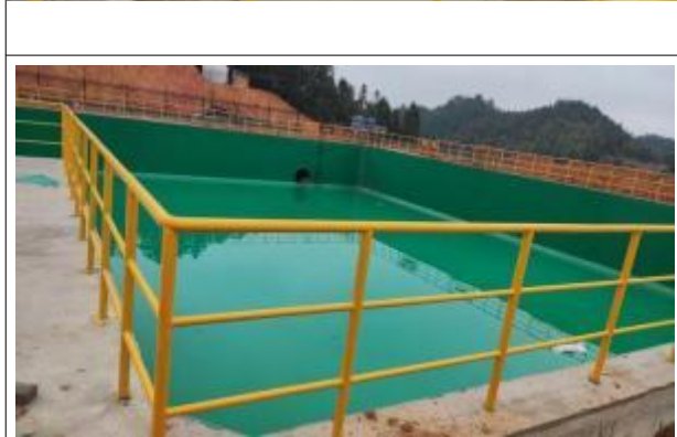
初期雨水池、污水站：夯实素土+不小于 200mm 厚水泥铺面+防渗五油三布+环氧树脂漆
