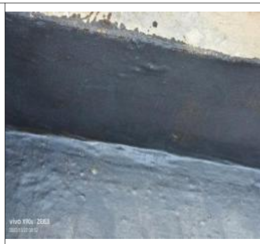
雨水沟防渗五油三布
