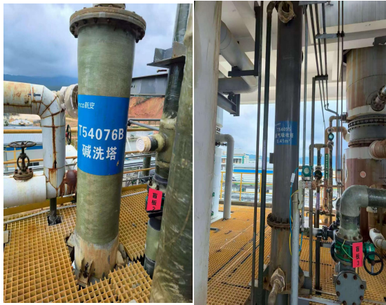
高纯盐酸 2#废气排气筒及废气处理设施
