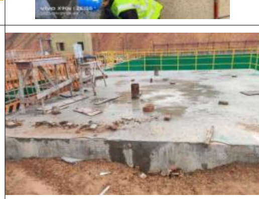
初期雨水池、污水站：夯实素土+不小于 200mm 厚水泥铺面+防渗五油三布+环氧树脂漆
