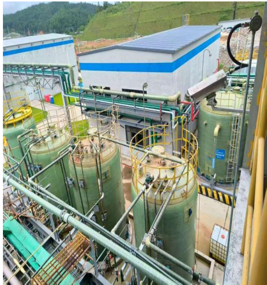
生产区缓冲罐尾气收集及废气处理
