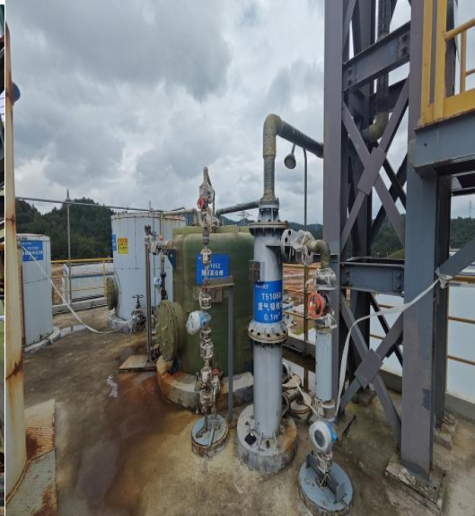
罐区废气排气筒及废气处理设施 一次盐水车间废气排气筒及废气处理设施
