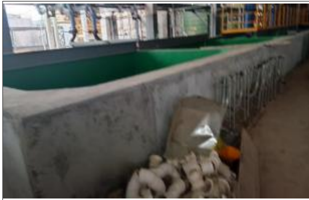
各种回收槽：夯实素土+不小于 200mm 厚水泥铺面+ 防渗五油三布+环氧树脂漆
