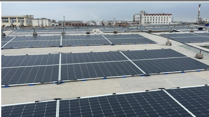
图2-13 混凝土屋面轻质组件安装项目实拍图
