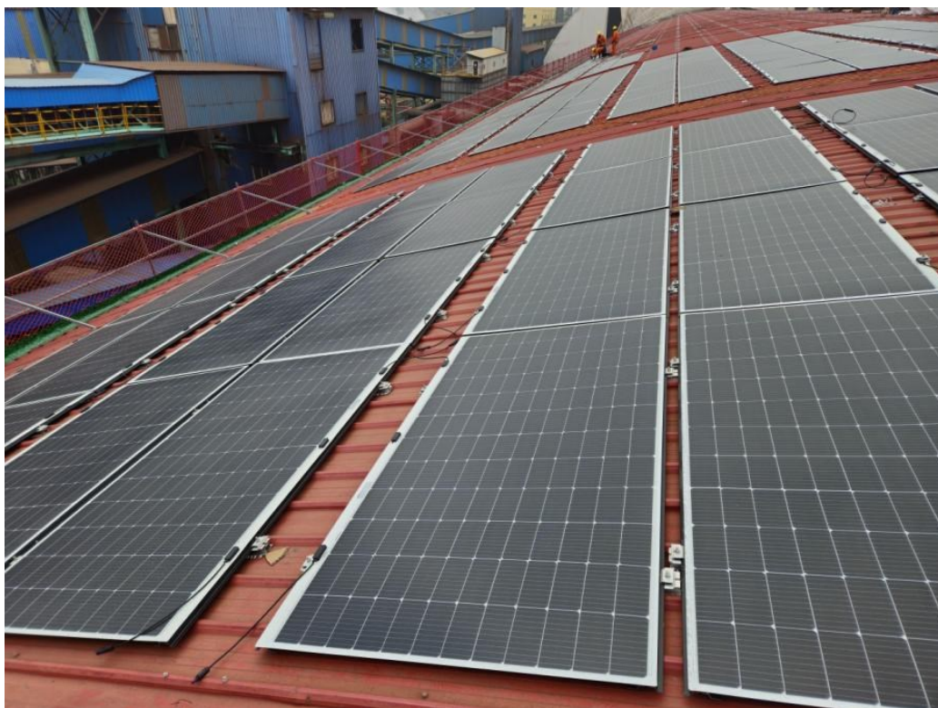
图2-10 彩钢瓦屋面轻质组件安装示意图二
