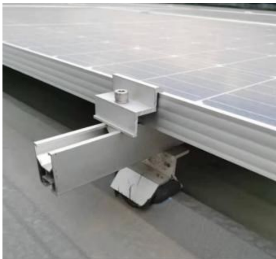
图2-5 梯型彩钢瓦屋面支架安装示意图
