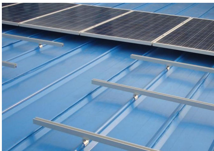
图2-6 角驰型彩钢瓦屋面支架安装示意图
