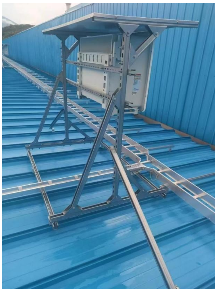
图2-14 逆变器支架安装示意图
