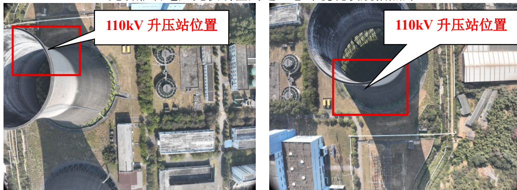
110kV 变电站于龙岩雁石电厂场址周边生态环境现状航拍照片
