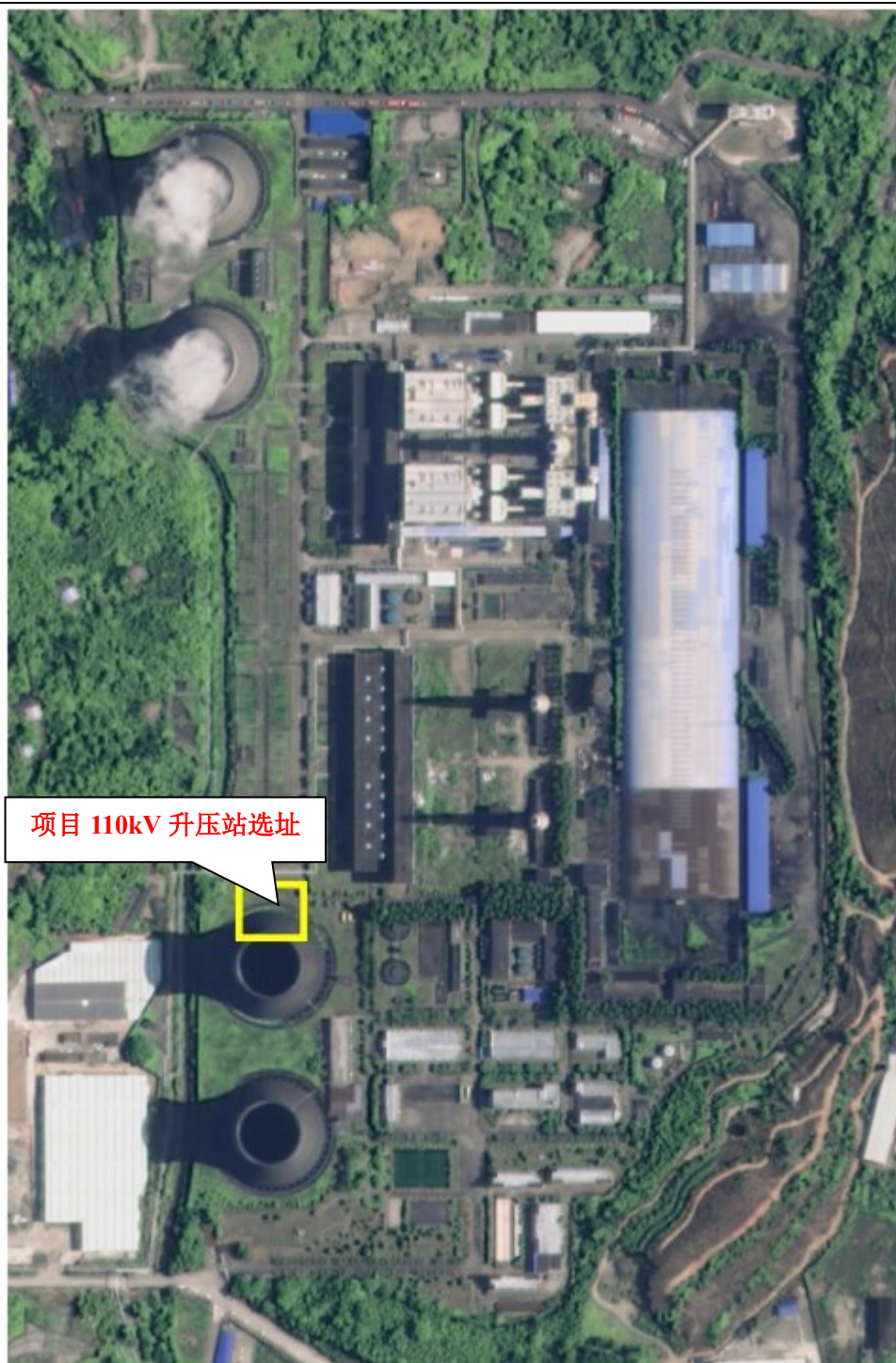
图 2-18 龙岩雁石电厂利用拆除原一期冷却塔后的空地原址建设升压站
