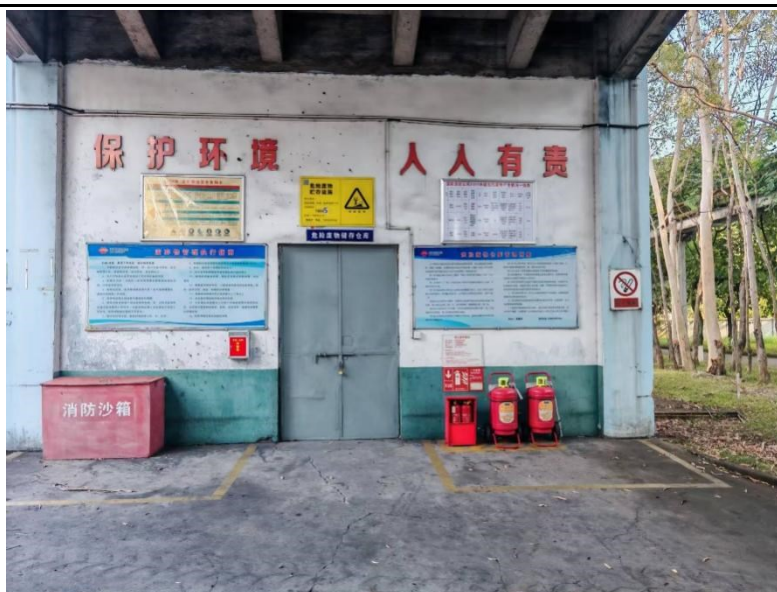
图 4-4 龙岩雁石电厂危废贮存间现状照片
