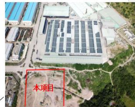
项目区东侧园区道路，隔道路为黑猫轮胎公司
