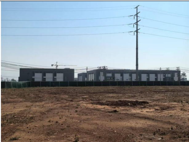
项目南侧：盛信混凝土有限责任公司
