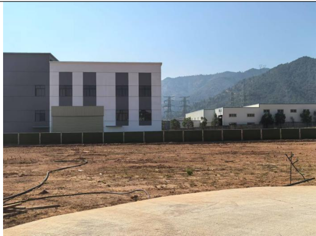
项目东南侧：省道
