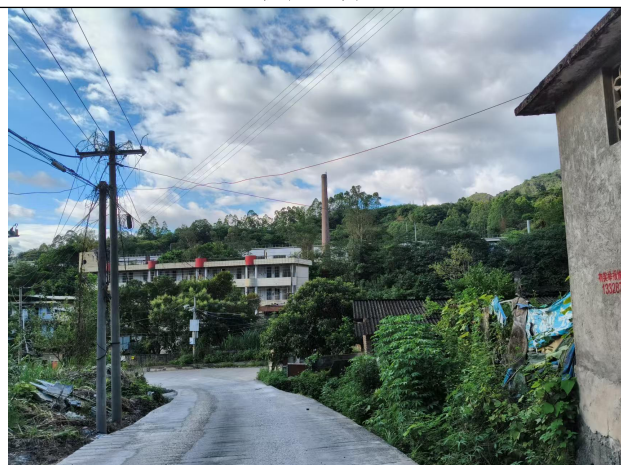
北侧废弃养老院
